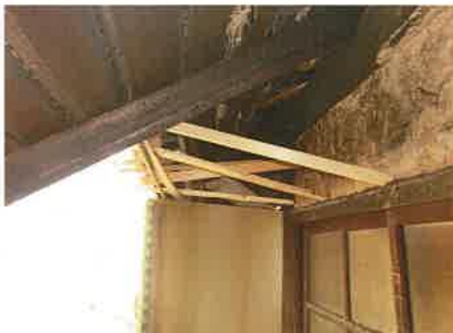
屋根の崩落を防ぐための処置がされた状況
