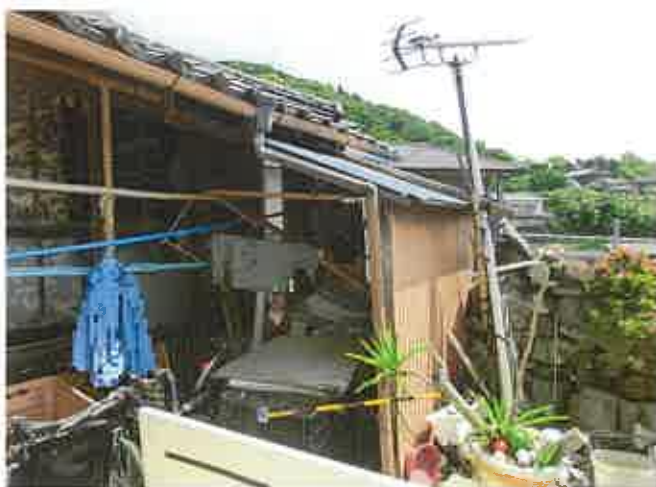
屋根の崩落を防ぐための処置がされた状況
