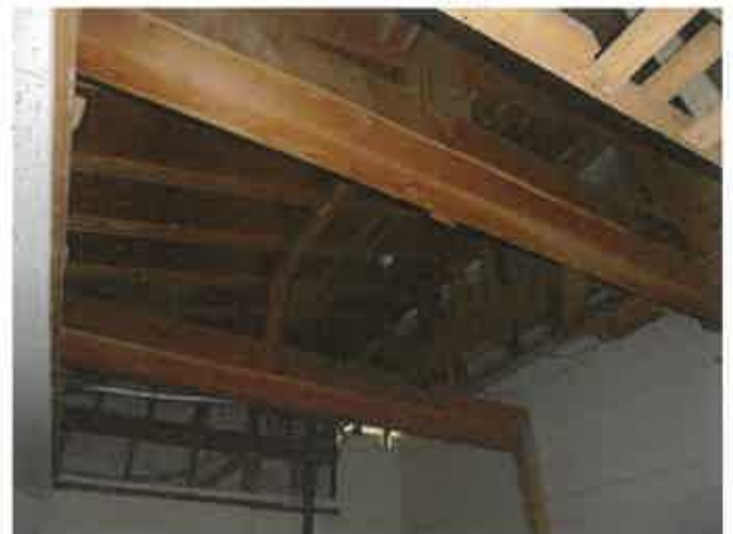
車庫天井の崩落状況
