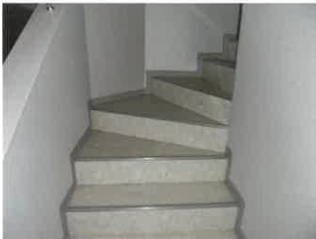
プールから2階への階段
