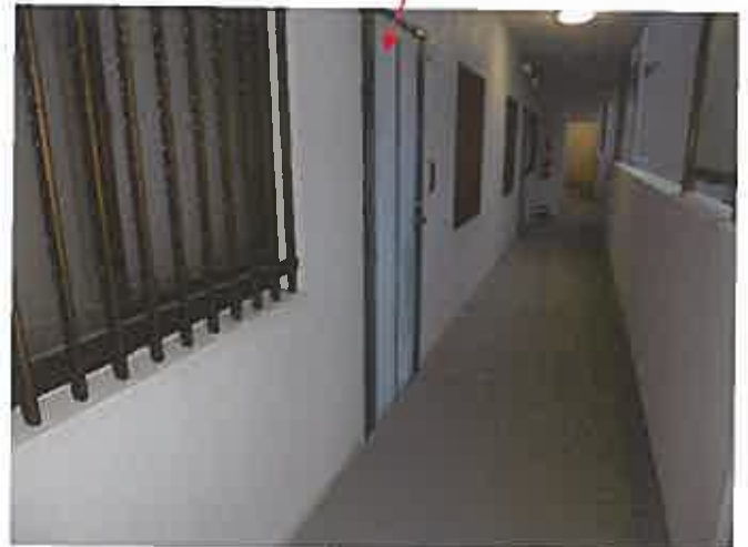
物件1 屋外廊下
