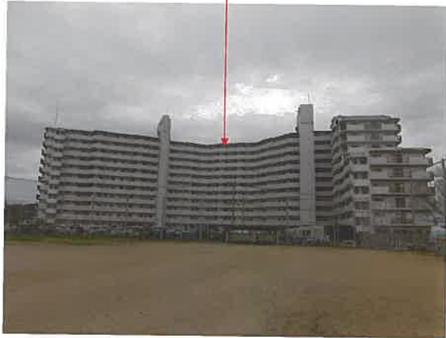
物件1を含む一棟の建物
