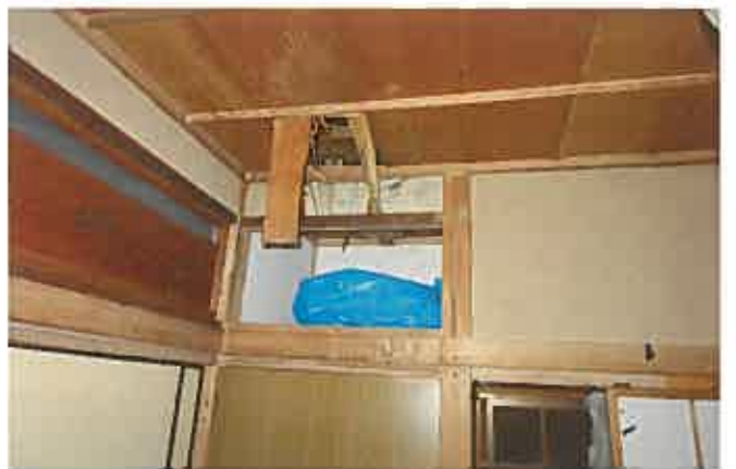
天井の損傷状況
