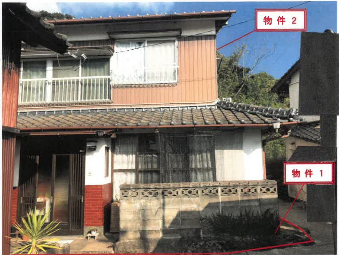
① 物件 1 及び物件 2 を南方より撮影
