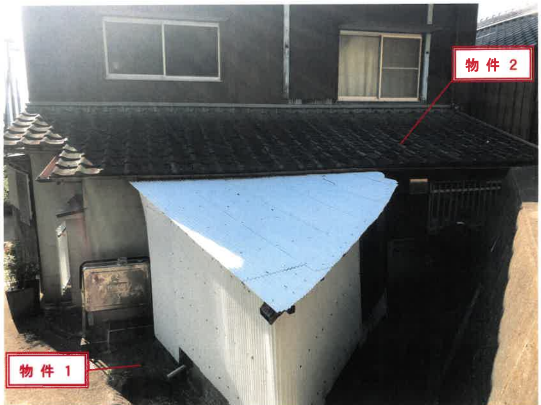
② 物件 1 及び物件 2 を北方より撮影
