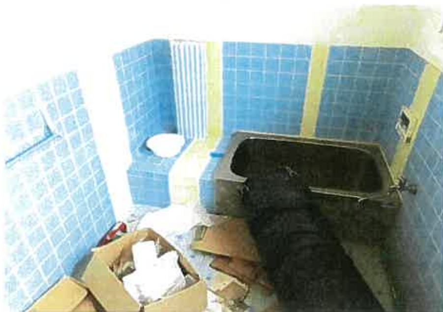
主たる建物の室内を撮影
