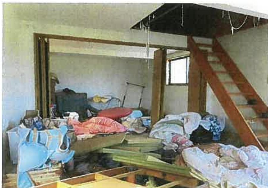
附属建物の室内を撮影
