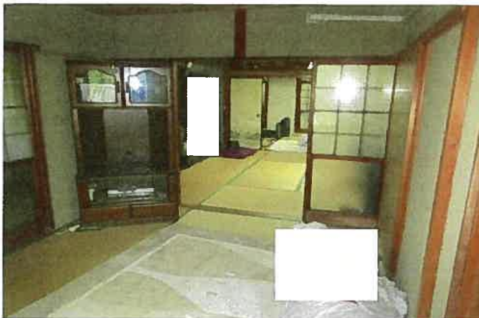
No. 4 本件建物の室内を撮影
