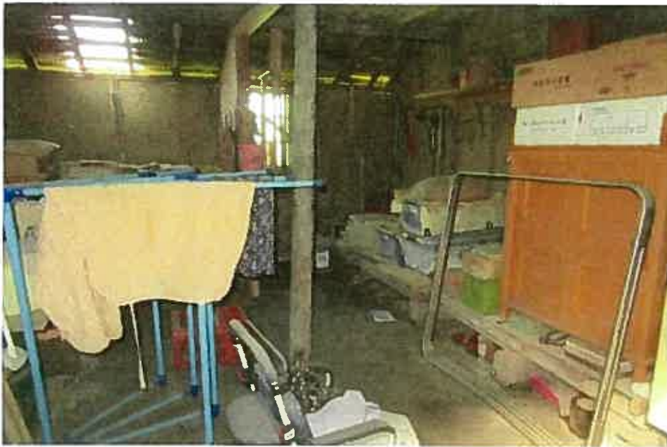
No. 10 付属建物の内部を撮影
