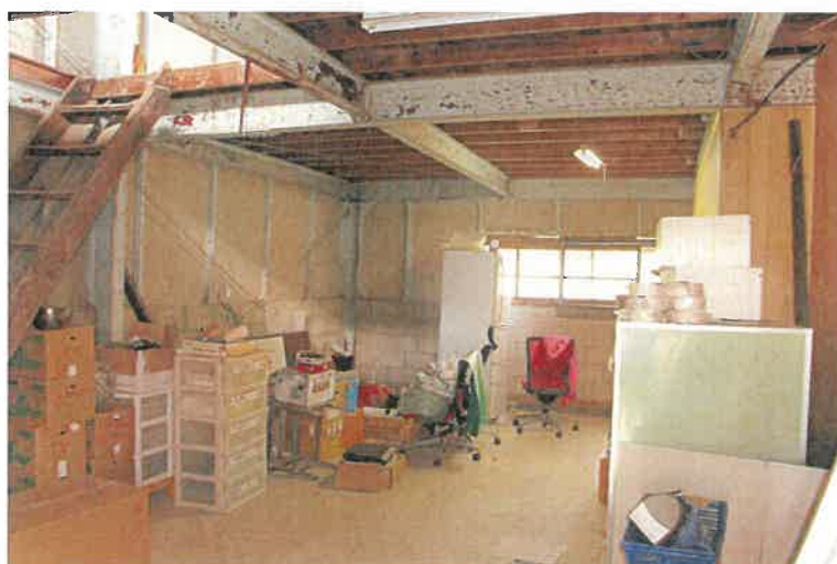
事務所 (物件7建物)
