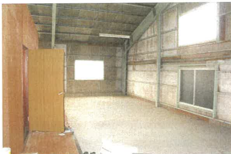
作業場兼倉庫
