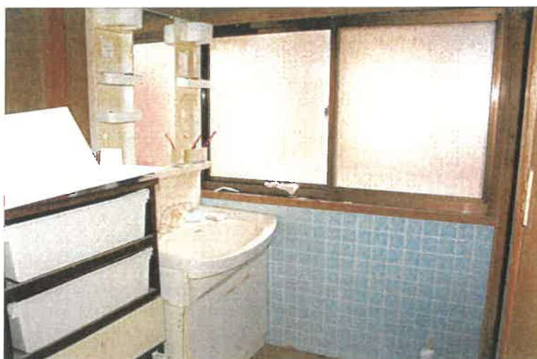
洗面所 (物件3建物)
