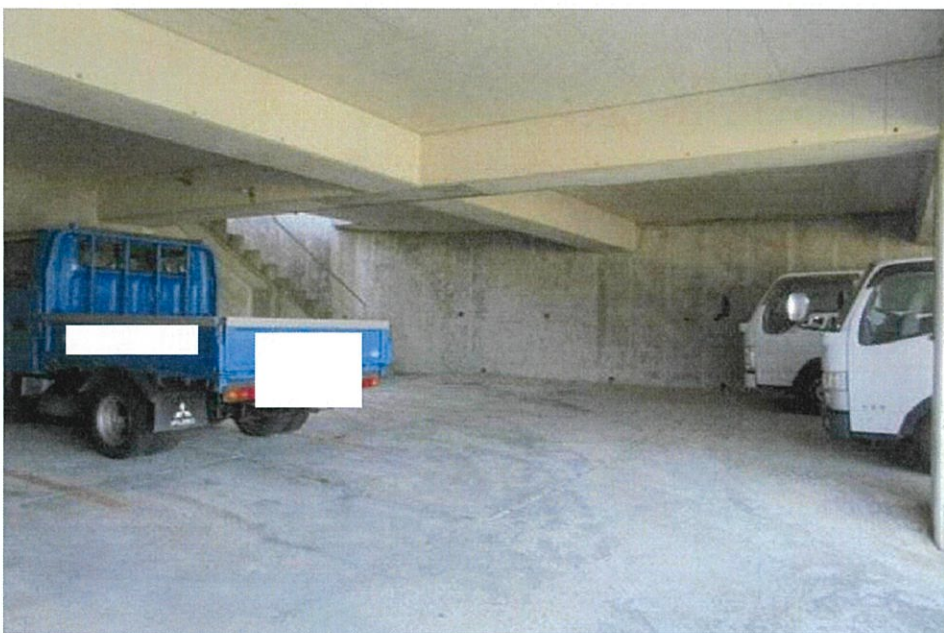
No. 12 附属建物（符号 2）の内部 を撮影
