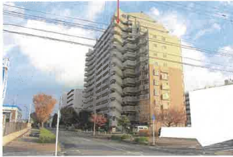
物件4建物が存するマンション
