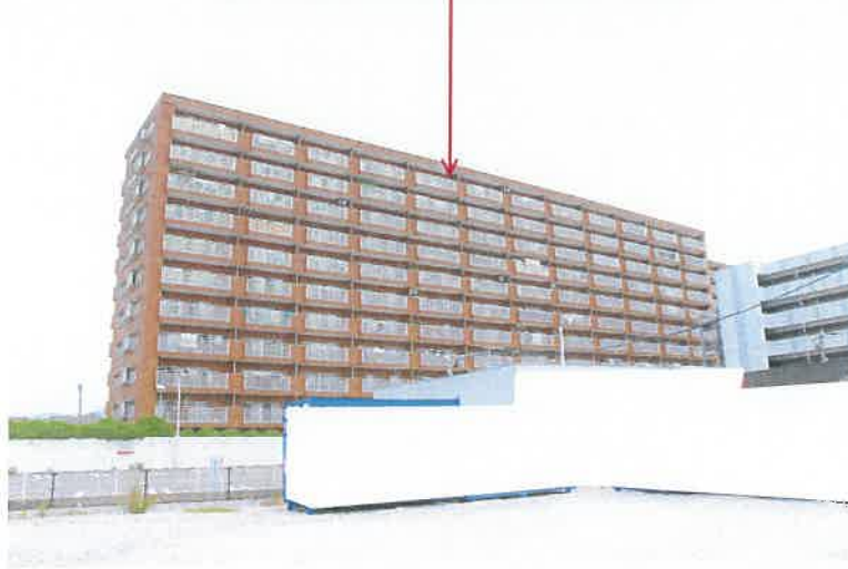
物件1 建物の存するマンション
