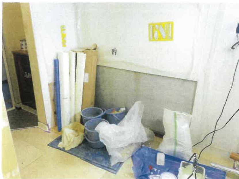
4 取り外し前の流し台設置場所付近
