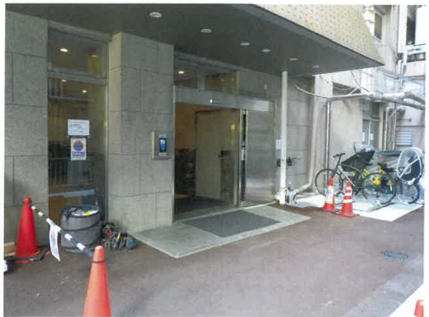
2 エントランス付近
