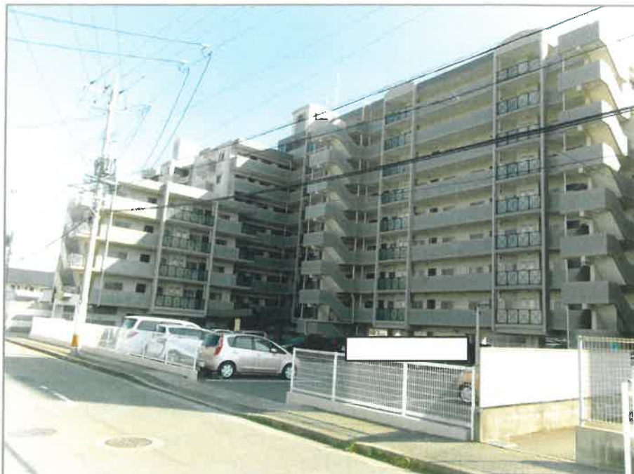
1 目的物件のある 一棟の建物の外観
