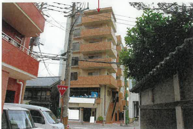
物件1 建物の存するマンション
