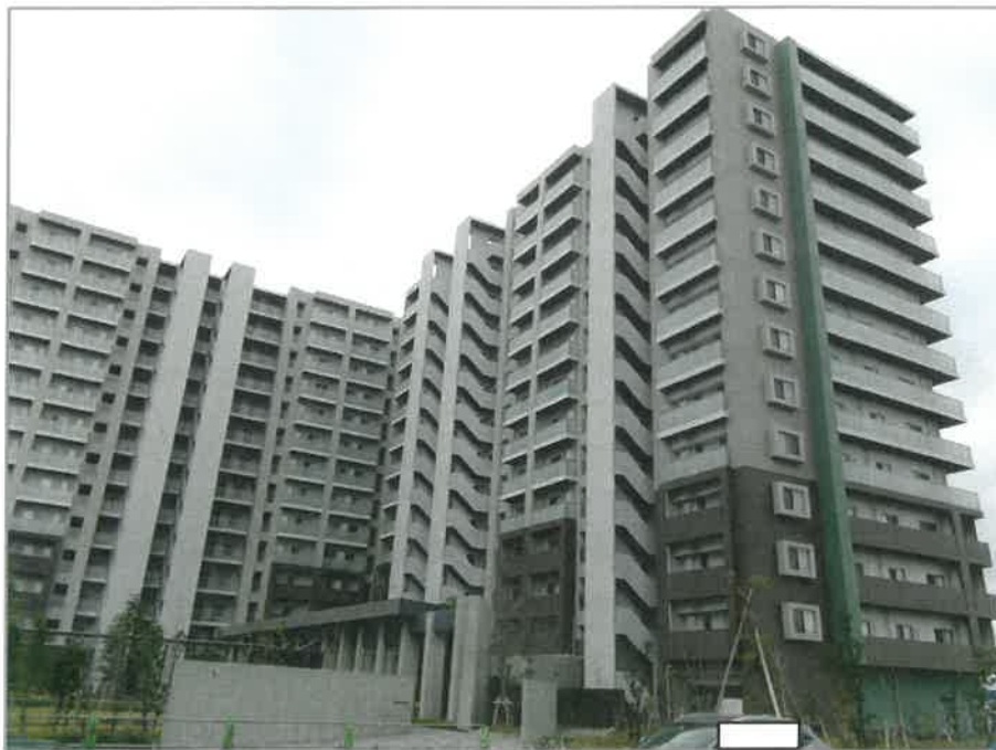
1 目的物件のある 一棟の建物の外観
