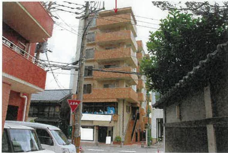
物件1 建物の存するマンション
