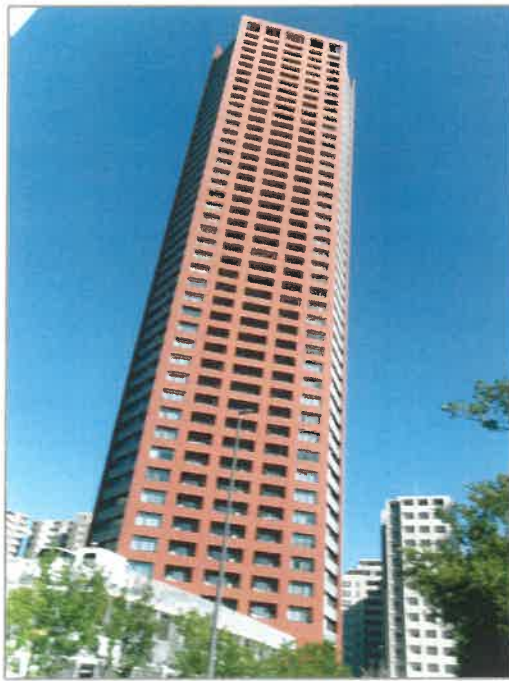
1 目的物件のある 一棟の建物の外観
