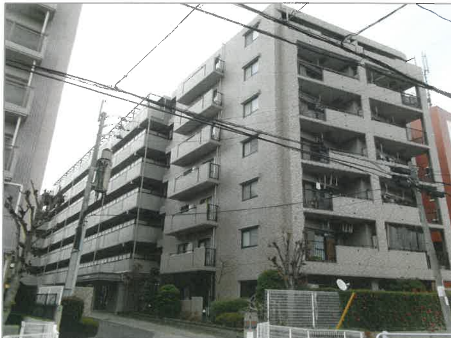
1 目的物件のある 一棟の建物の外観
