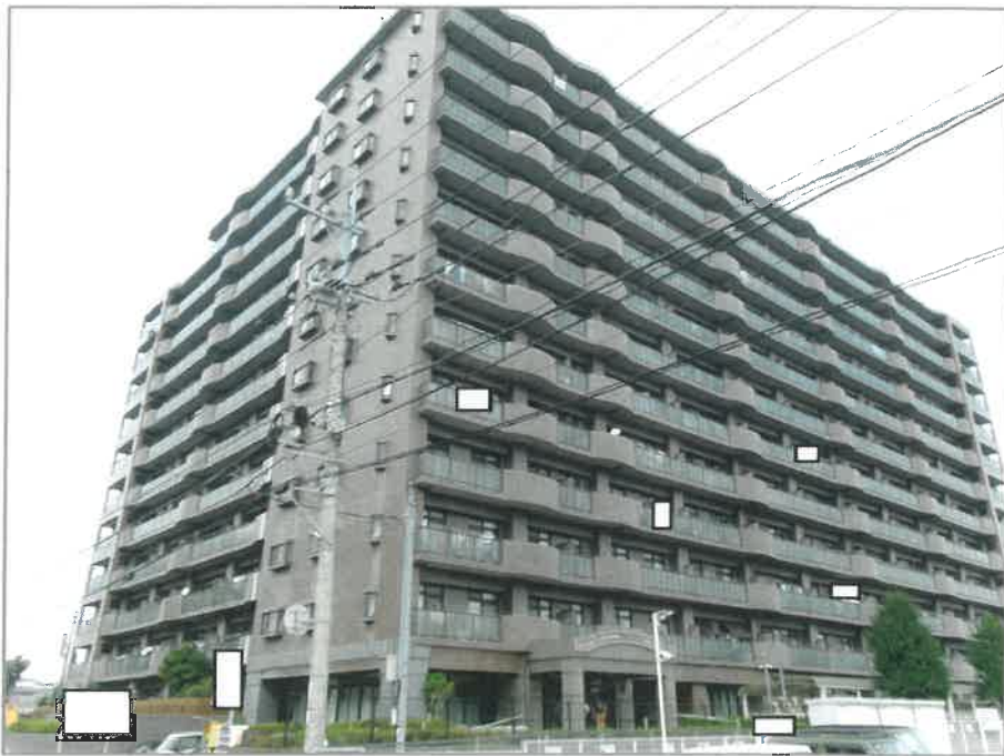
1 目的物件のある 一棟の建物の外観
