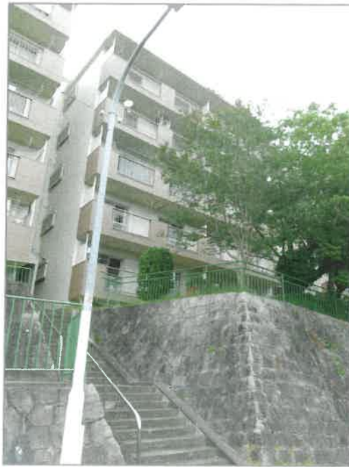
1 目的物件のある 一棟の建物の外観
