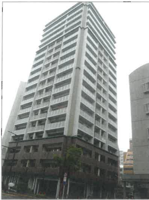
1 目的物件のある 一棟の建物の外観
