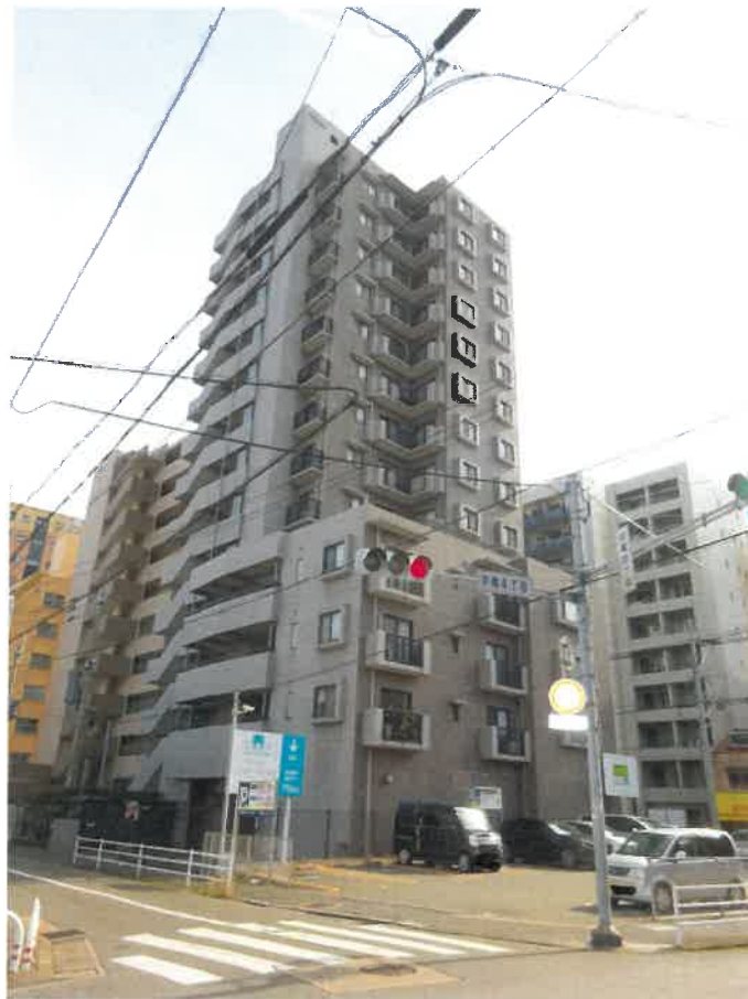
9 本件マンション 北西側接面道路等
