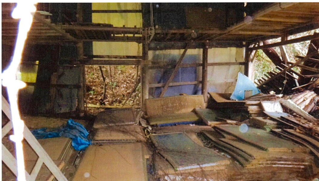
小屋(工作物)の内部
