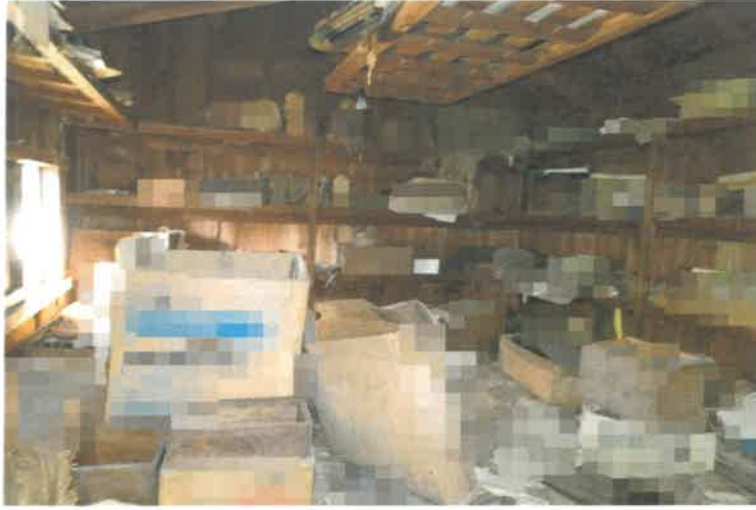
写真 2 2 附属建物符号 3 内の状況
