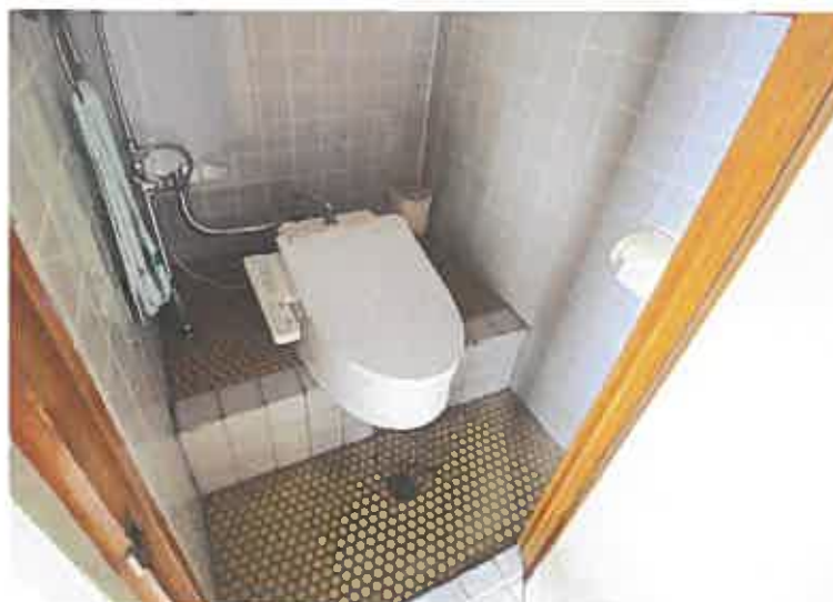
写真9（物件3建物1階トイレ）
