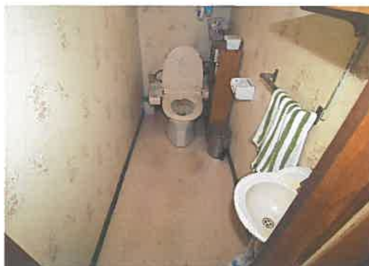
写真 1 2 （物件 2 建物 2 階トイレ）
