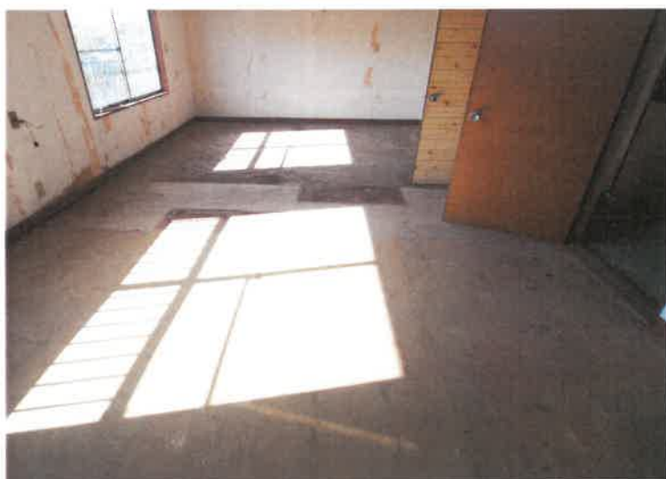
写真9 (主建物2階南側洋室)
