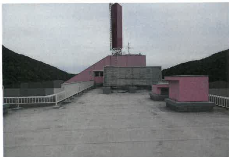
写真81 物件2主建物・5階屋上
