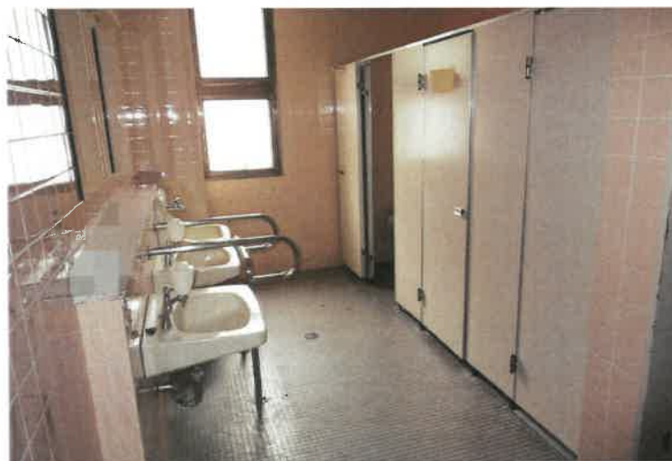
写真 5 7 物件 2 主建物・3 階女性用トイレ
