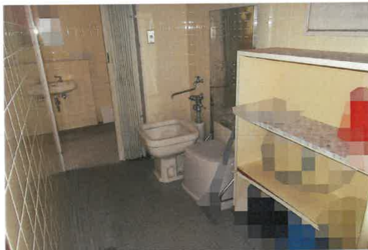
写真 5 8 物件 2 主建物・3 階汚物処理室
