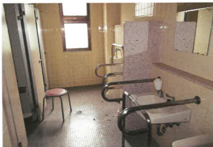
写真4 5 物件2主建物・2階男性用トイレ
