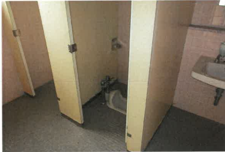
写真6 4 物件2主建物・4階西側トイレ
