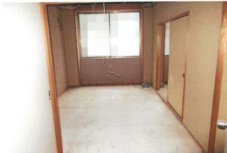
写真 6 8 物件 2 主建物・4 階寮室 1（寮室 3～5 は同型）
