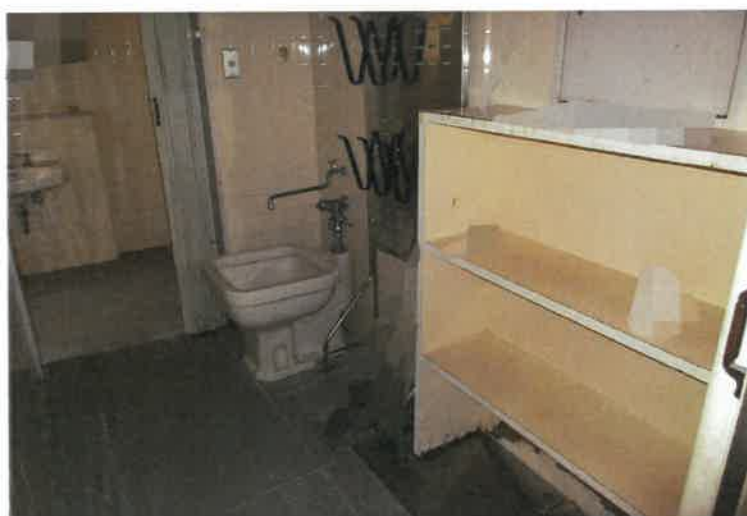
写真4 4 物件2主建物・2階汚物処理室
