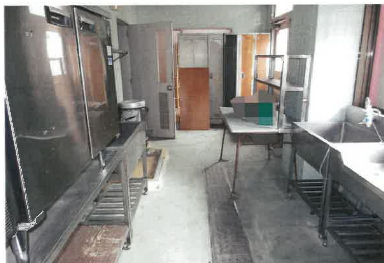
写真20 物件2主建物・1階厨房2
