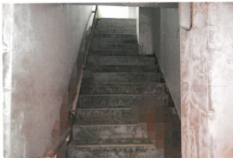
写真 9 7 物件 4 建物・1 階倉庫 4 北西側階段部分
