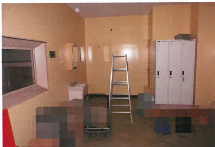
写真 3 2 物件 2 主建物・1 階女子更衣室 2
