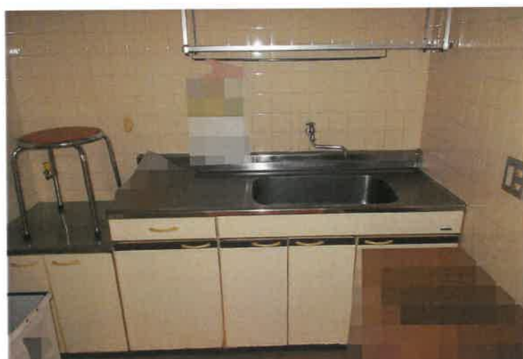
写真35 物件2主建物・2階湯沸室
