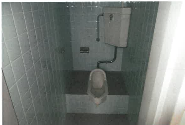
写真 2 2 物件 2 主建物・1 階休憩室横トイレ
