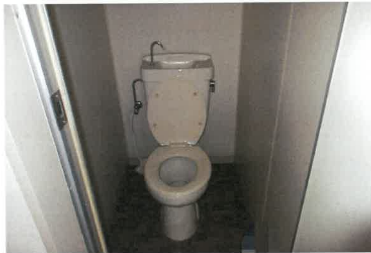
写真 7 7 物件 2 主建物・4 階更衣室西側トイレ
