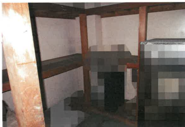
写真 2 4 物件 2 主建物・1 階倉庫 2
