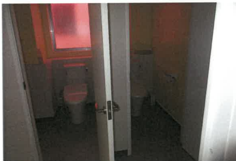
写真 8 6 物件 4 建物・1 階洋式トイレ
