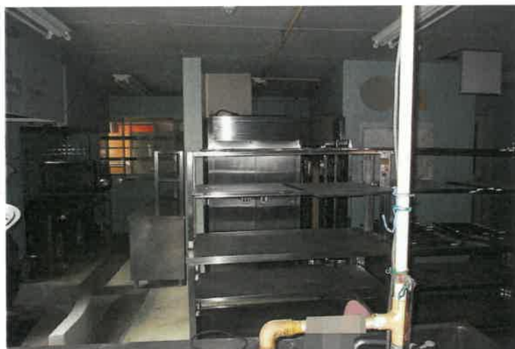
写真19 物件2主建物・1階厨房1
