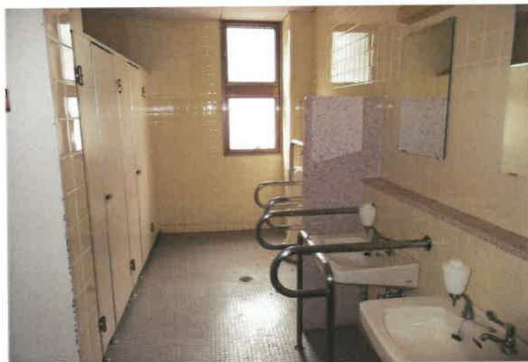
写真 5 9 物件 2 主建物・3 階男性用トイレ
