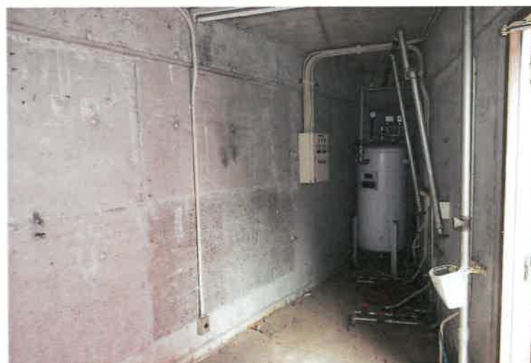
写真 8 3 物件 2 附属建物・倉庫 2
