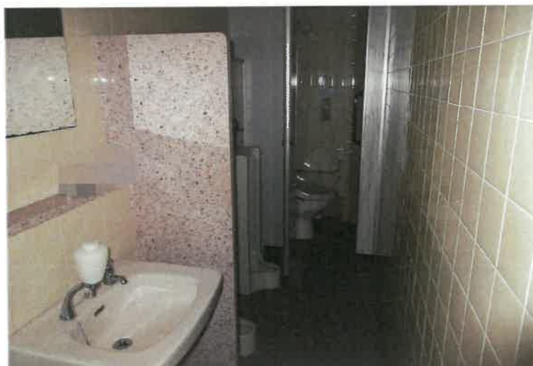
写真15 物件2主建物・1階東側男性用トイレ
