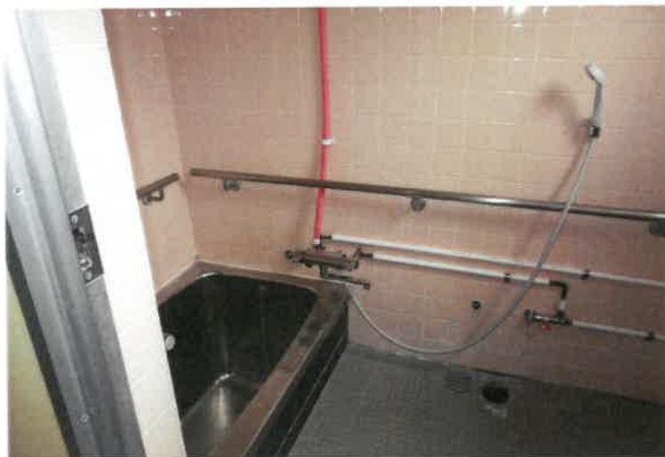
写真 4 2 物件 2 主建物・2 階浴室
