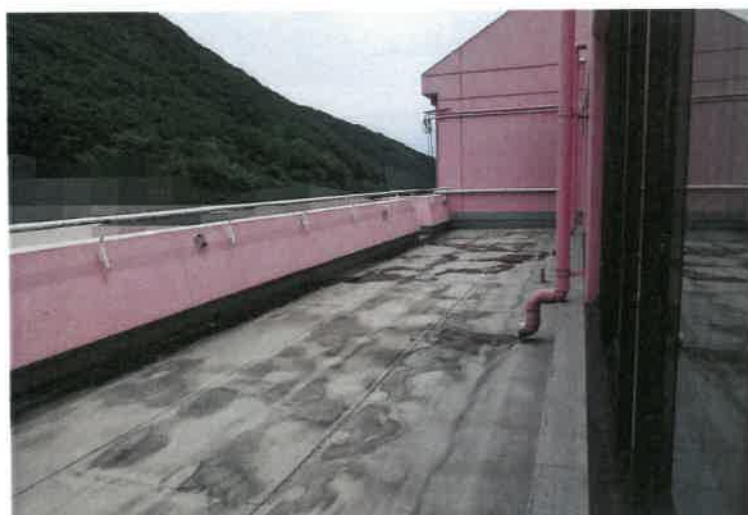
写真 7 5 物件 2 主建物・4 階屋上
