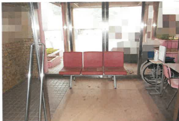
写真10 物件2主建物・1階風除室
