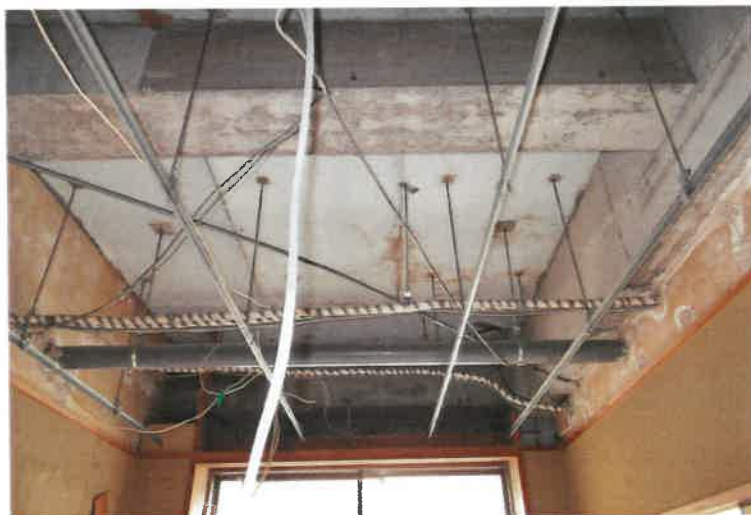
写真 6 9 物件 2 主建物・4 階寮室 1 天井部分（寮室 3～5 は同型）
