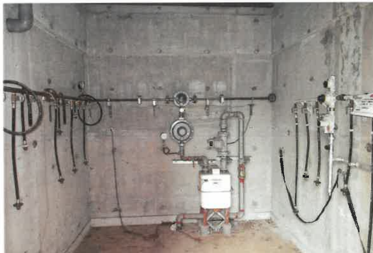
写真 8 2 物件 2 附属建物・倉庫 1
