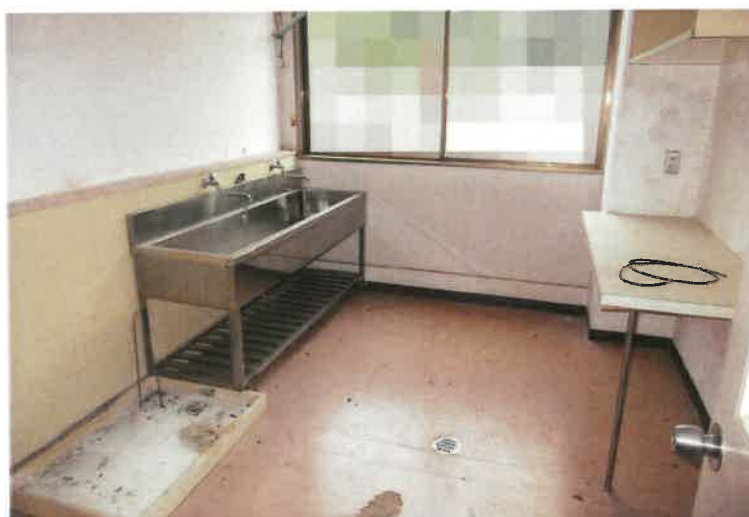
写真 7 2 物件 2 主建物・4 階洗濯室
