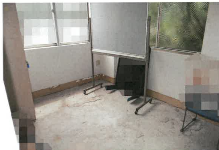
写真117 物件4建物・3階休憩室3（床板なし）
