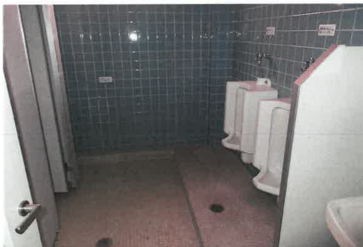
写真 1 1 2 物件 4 建物・2 階トイレ
