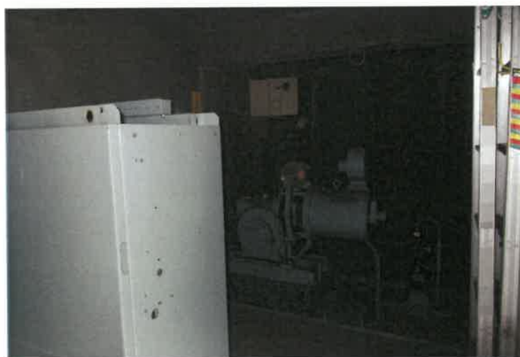
写真80 物件2主建物・5階E V機械室
