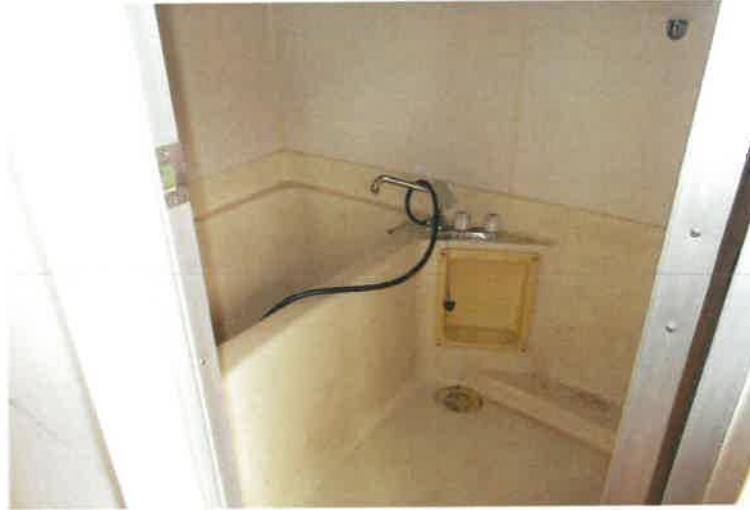
写真 7 6 物件 2 主建物・4 階更衣室西側浴室
