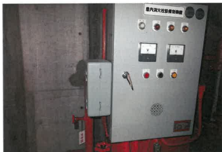
写真 2 3 物件 2 主建物・1 階倉庫 1
