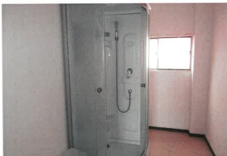
写真120 物件4建物・3階シャワー室
