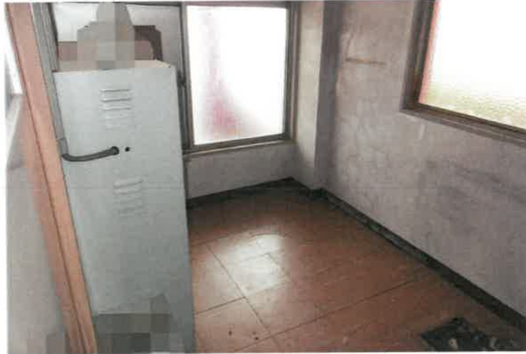
写真 9 4 物件 4 建物・1 階倉庫 1
