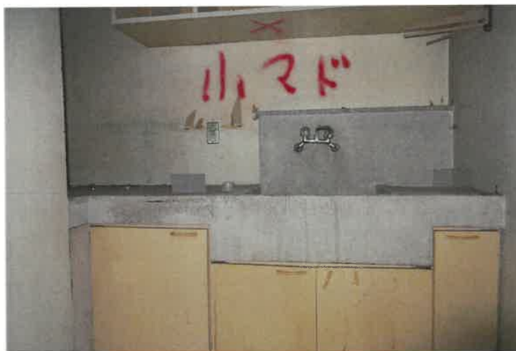
写真 3 1 物件 2 主建物・1 階倉庫 5 北側簡易キッチン部分（未完成）
