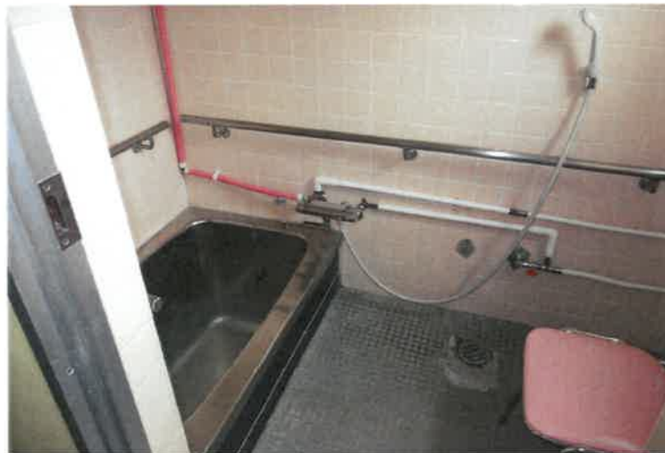
写真 5 6 物件 2 主建物・3 階浴室
