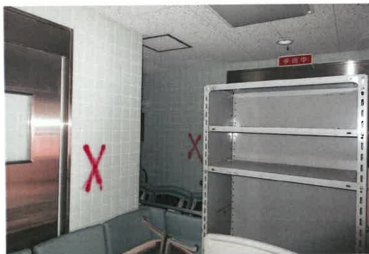
写真 7 8 物件 2 主建物・4 階手術準備ホール
