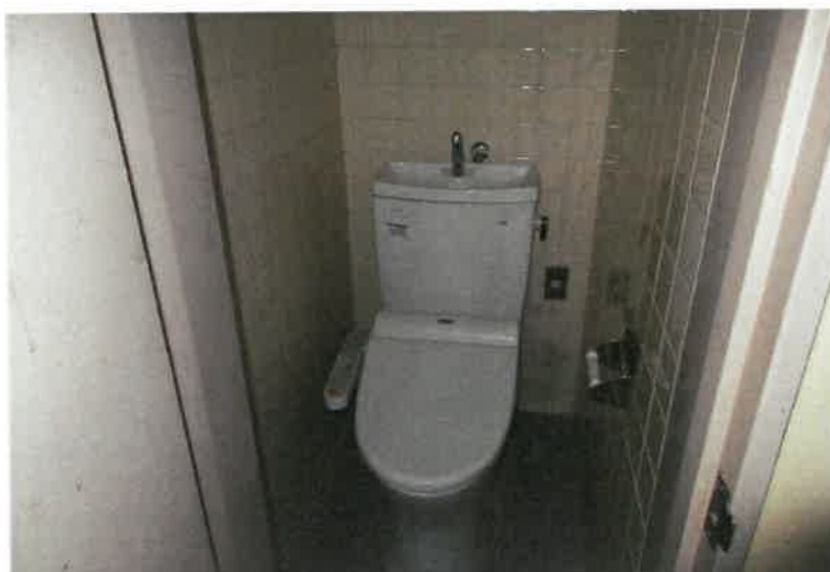
写真 3 3 物件 2 主建物・1 階女子更衣室 2（トイレ部分）
