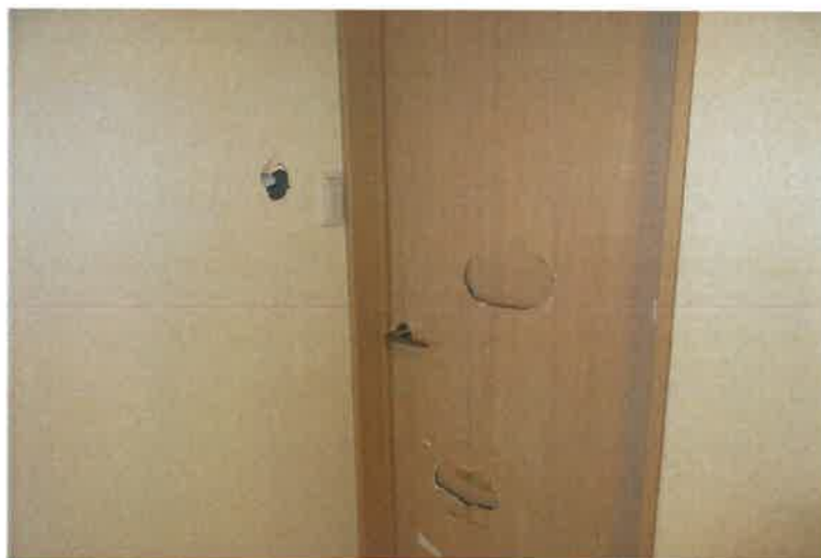
写真16 2階南側洋室（ドア・壁部分）
