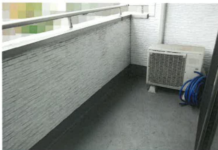
写真18 2階バルコニー
