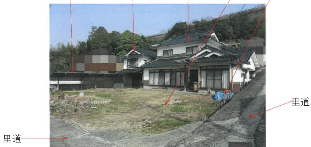
写真1 カ-ポ-ト 物件2 附属建物・主建物 物件1 土地 井戸
