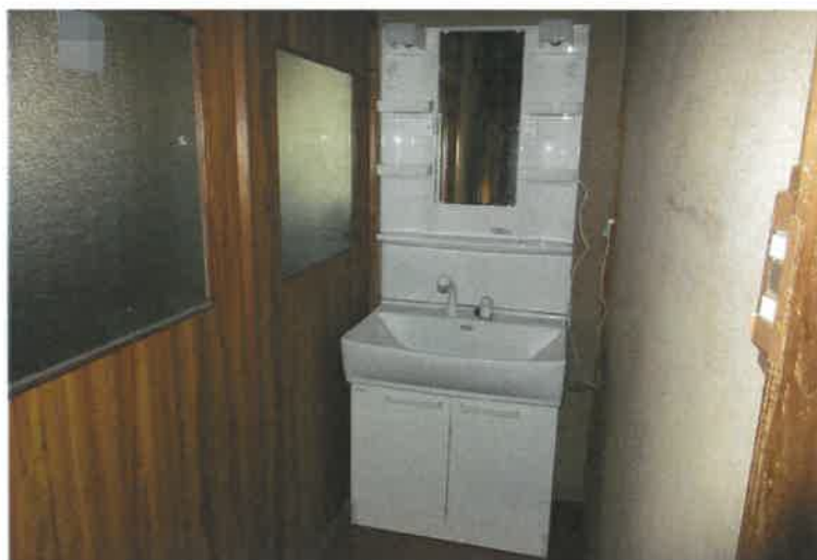
写真8 主建物・1階洗面所
