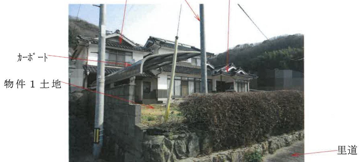
写真2 物件2 附属建物 電柱 物件2 主建物
