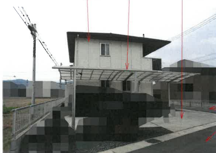
写真3 物件3 建物 カポート 物件1 土地
