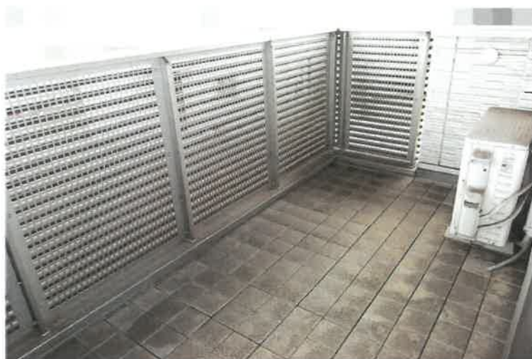
写真20 2階バルコニー
