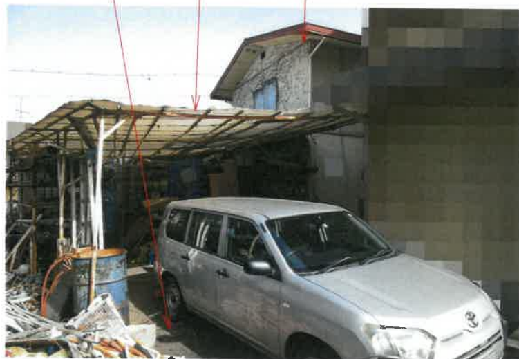
写真 3 物件 3 土地 下屋 物件 4 建物
