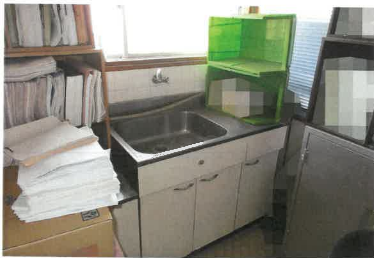
写真10 2階南東側事務所（簡易キッチン部分）
