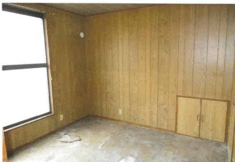
写真1 5 2階洋室（床板張り替え途中）
