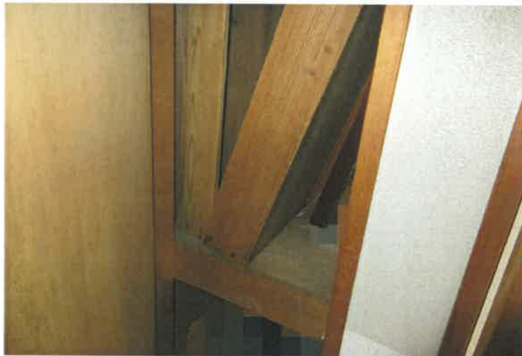
写真5 1階物入（トイレ横）
