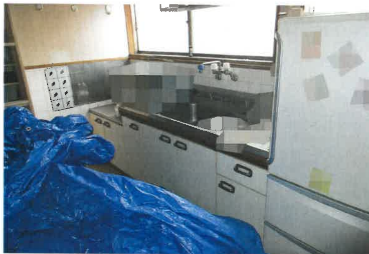
写真8 1階台所（キッチン部分）
