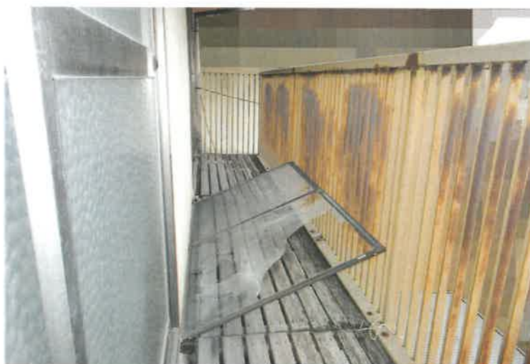
写真17 2階バルコニー
