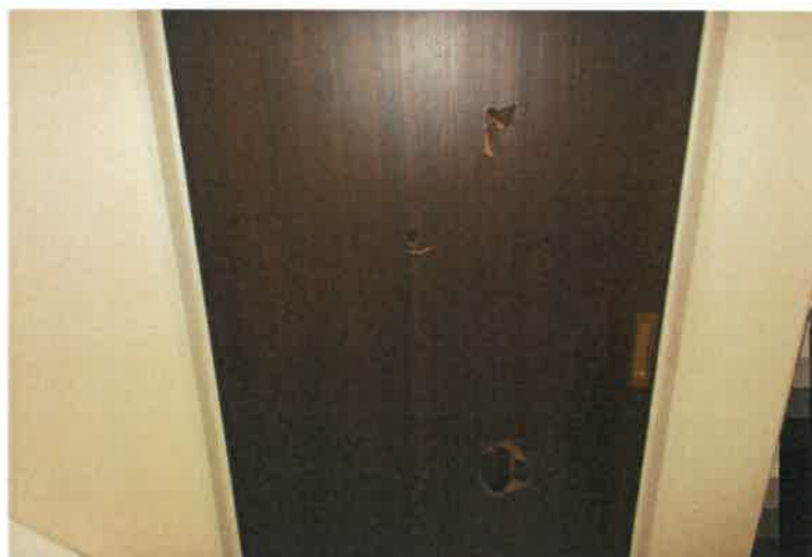
写真38 物件4建物・2階西側洋室（引き戸）
