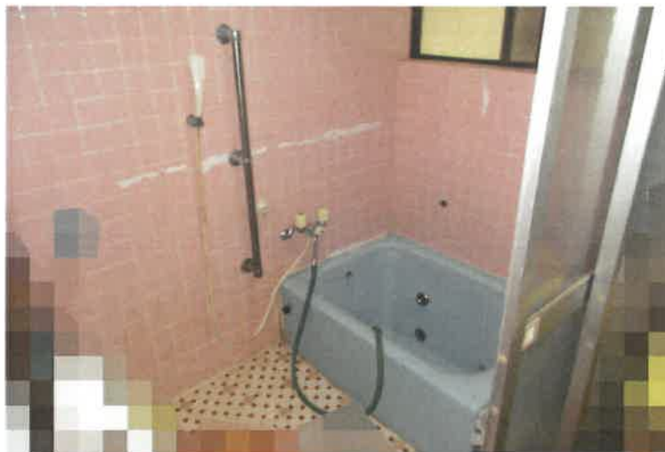
写真10 物件2建物・1階浴室
