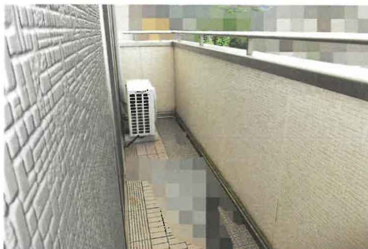
写真4 3 物件4建物・2階バルコニー
