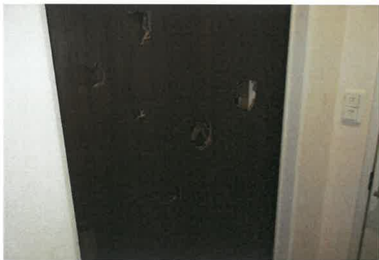
写真3 6 物件4建物・2階北西側洋室（引き戸）
