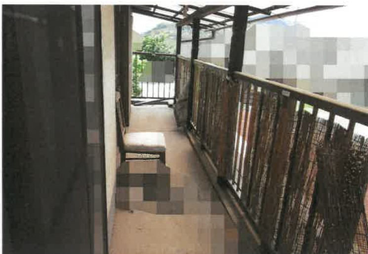
写真 2 4 物件 2 建物・2 階ベランダ
