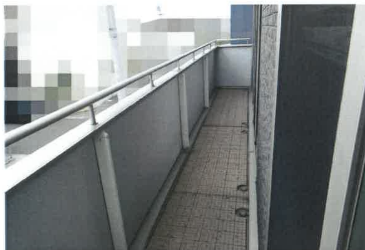
写真17 2階バルコニー
