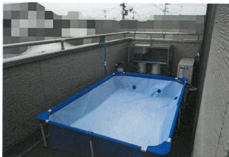
写真17 2階ルーフバルコニー
