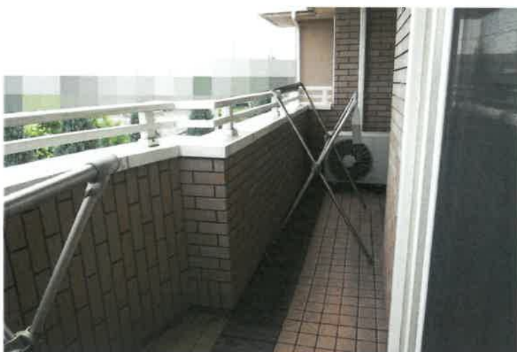
写真 2 7 2 階南東側バルコニー
