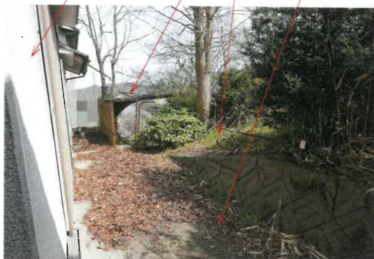
写真3 物件2建物（主） 下屋 法面 物件1土地
