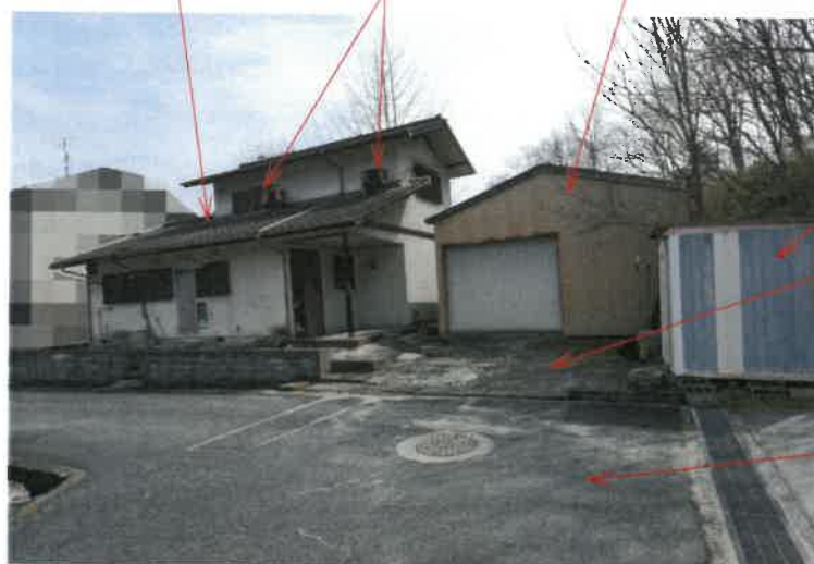
写真2 物件2建物（主） 室外機 物件2建物（未登記附属建物）
