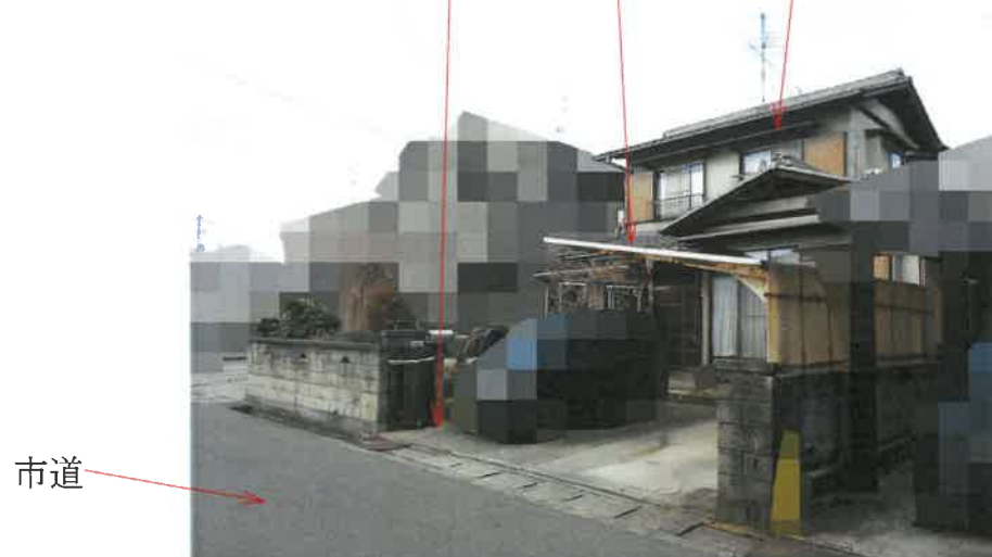
写真2 物件4土地 カーポート 物件5建物
