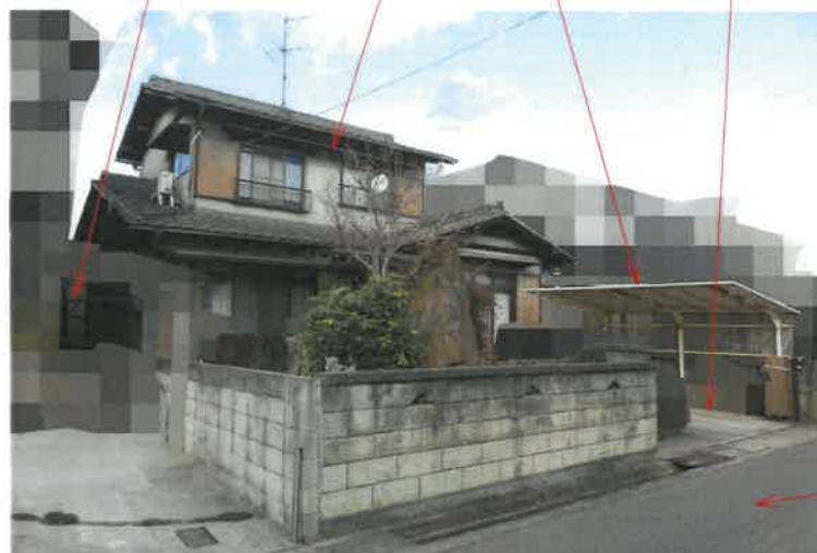
写真1 下屋状の工作物 物件5建物 カーポート 物件4土地
