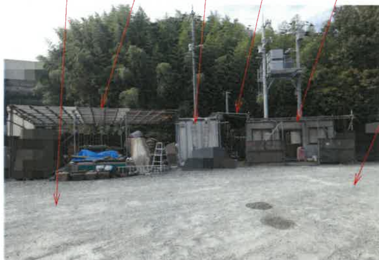
写真5 物件1土地 下屋 簡易物置 下屋 簡易事務所 物件2土地
