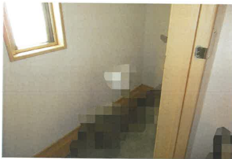
写真4 1階玄関東側物入
