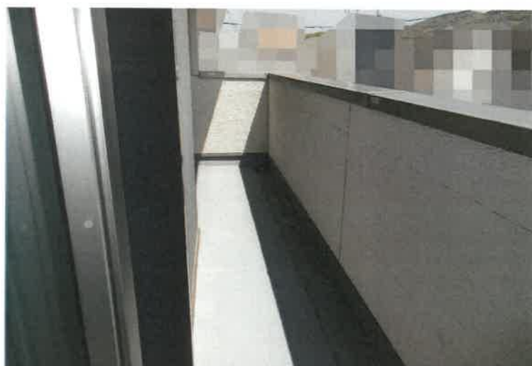
写真17 2階バルコニー
