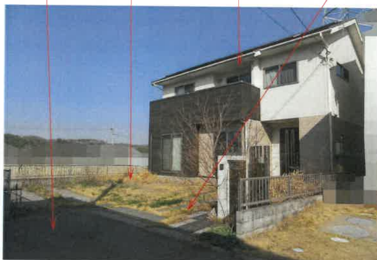
写真1 市道 物件1 土地 物件3 建物 物件2 土地
