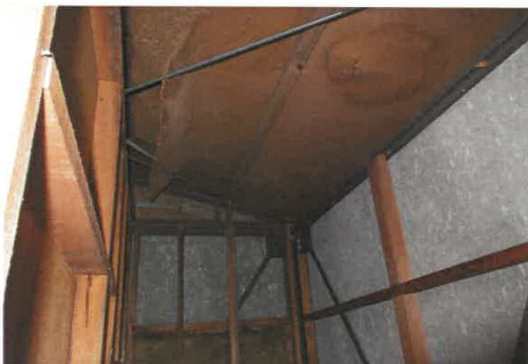
写真1 4 2階階段部分・天井
