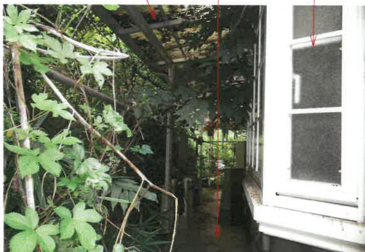
写真3 下屋 物件1 土地 物件2 建物
