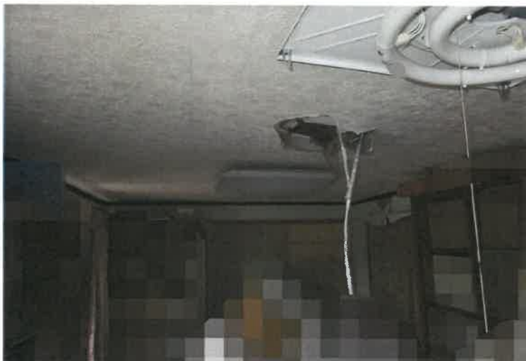
写真20 2階東側洋室（天井部分）
