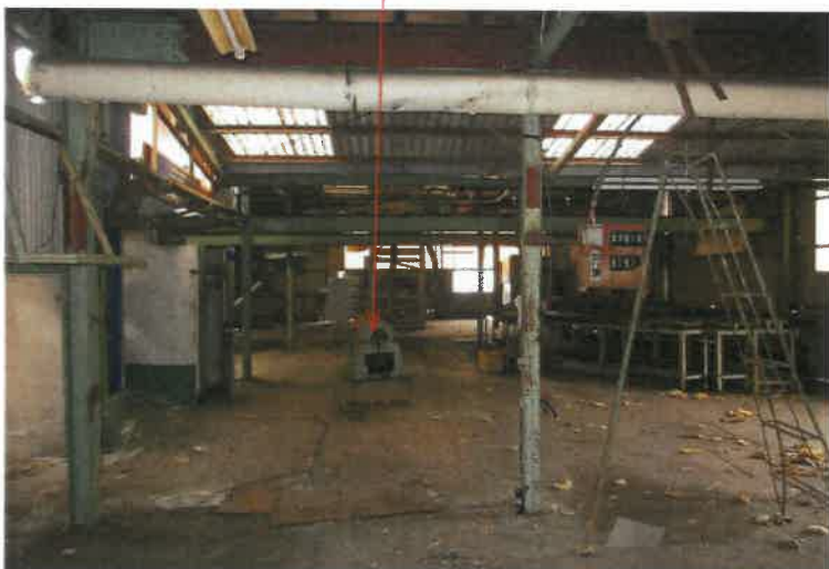
写真9 1階中央部分 材料送り機
