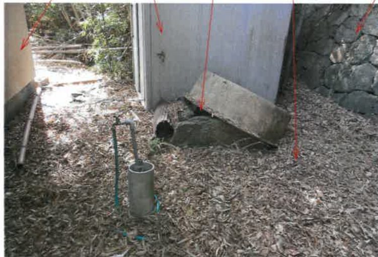
写真5 物件2建物 簡易物置 井戸 物件1土地 石垣擁壁
