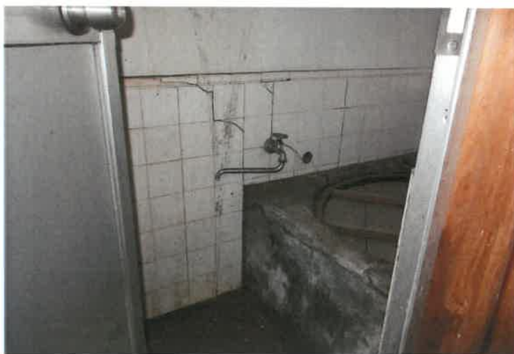
写真9 物件2建物・浴室
