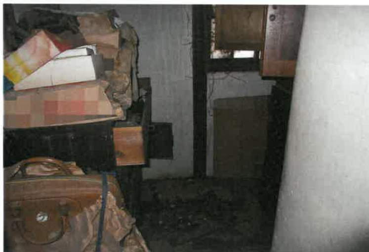
写真21 物件2建物・北西側物置
