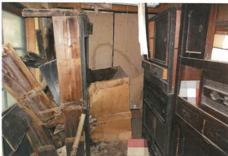
写真15 物件2建物・小上がり東側物置
