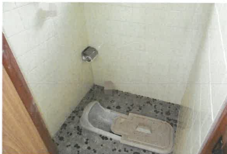
写真7 物件2建物・トイレ
