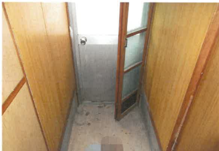
写真28 物件3建物・勝手口
