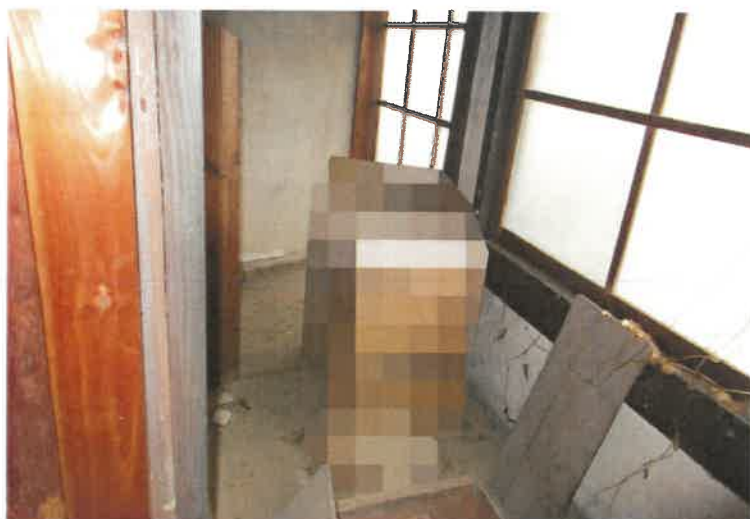
写真13 物件2建物・玄関東側物置
