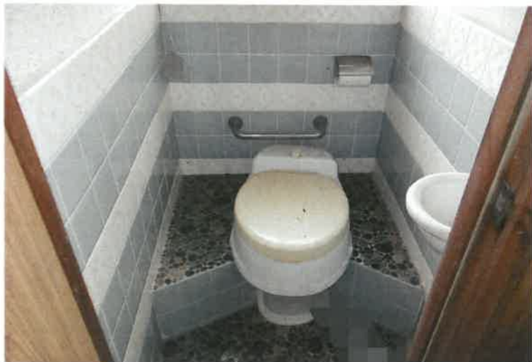
写真 2 4 物件 3 建物・トイレ
