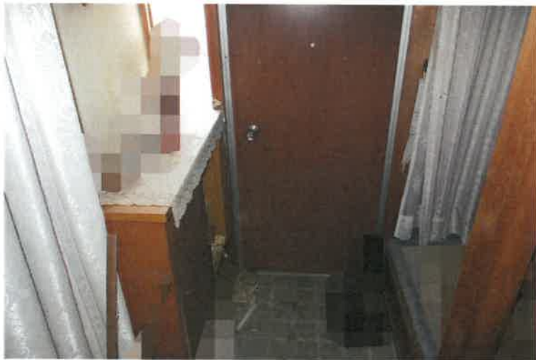
写真 2 3 物件 3 建物・玄関
