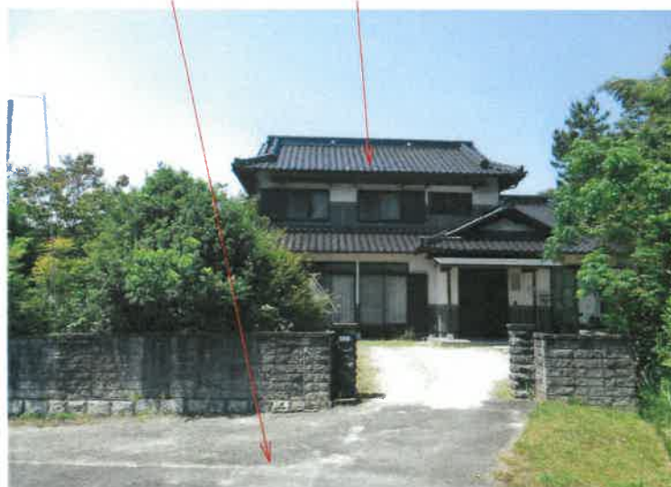
写真2 物件1土地 物件3主建物
