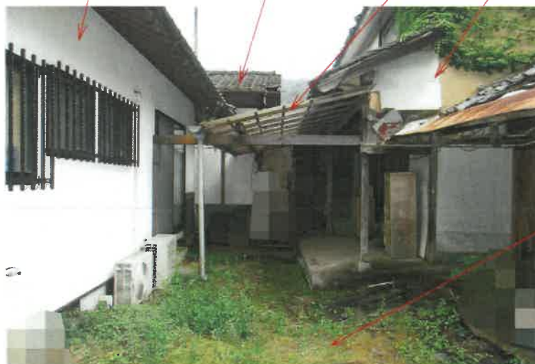
写真4 物件3主建物 物件3附属建物 下屋 物件2建物
