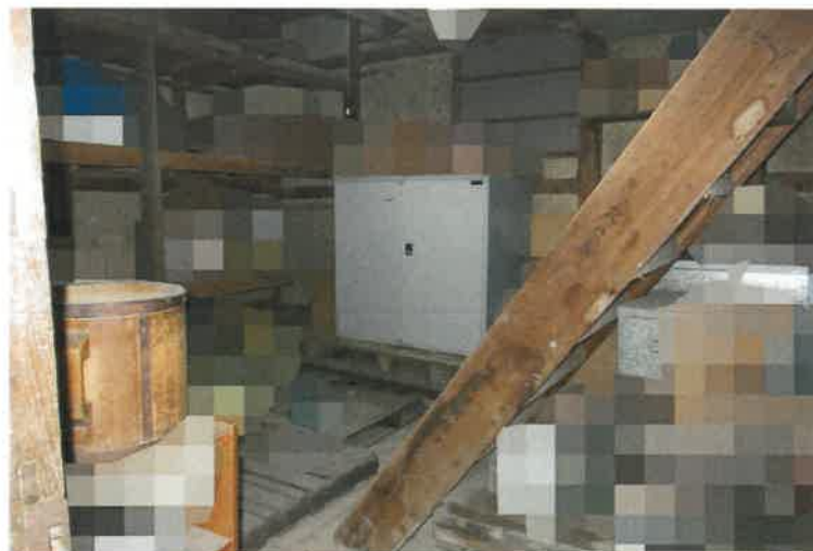
写真28 物件2建物・1階西側物置
