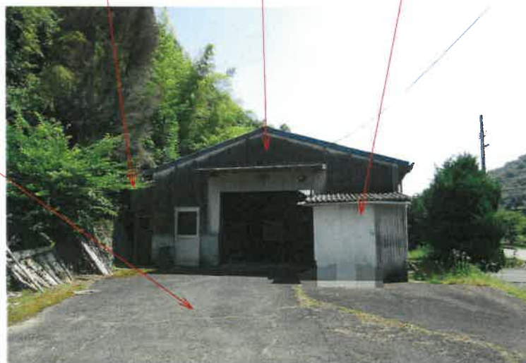
写真3 未登記増築部分 物件4建物 簡易物置
