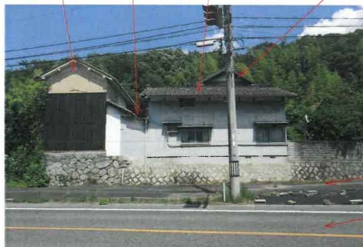
写真1 物件2建物 下屋 物件3附属建物 物件3主建物
