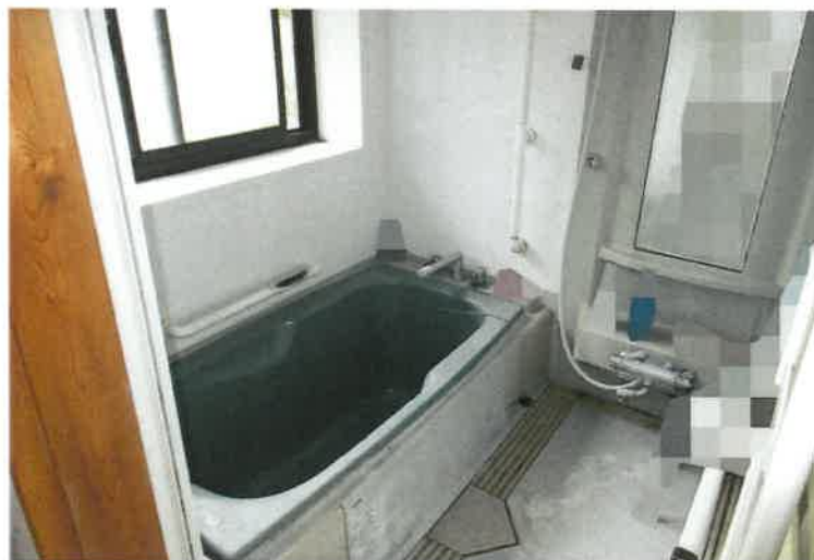
写真12 物件3主建物・1階浴室
