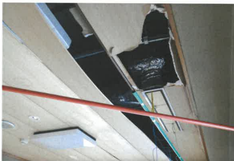
写真 3 8 2階北西側休憩室の天井(雨漏り)の状況
